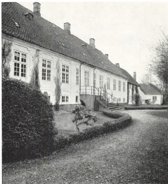
Hovedbygningen set fra haven (fot. Niels Elswing).
