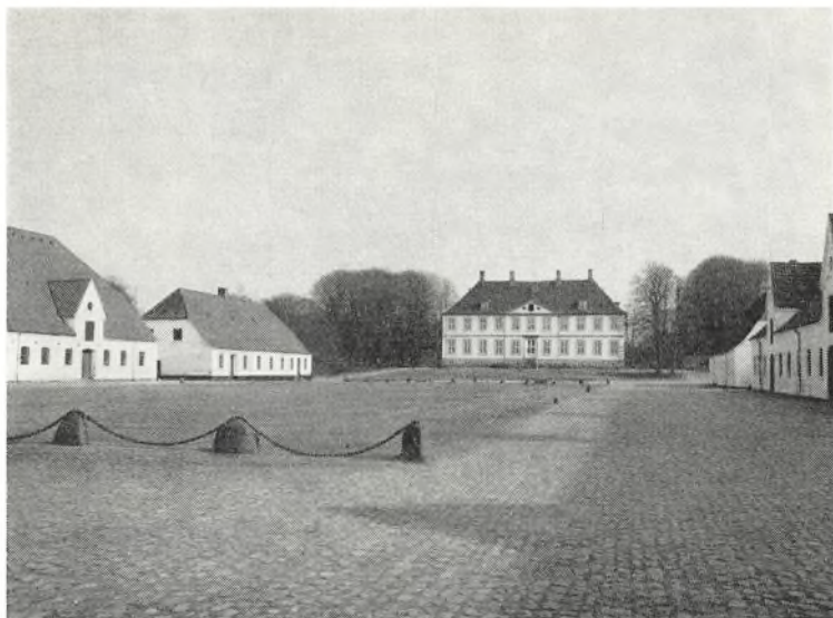
Hovedbygningen set fra nordvest (fot. Niels Elswing).
