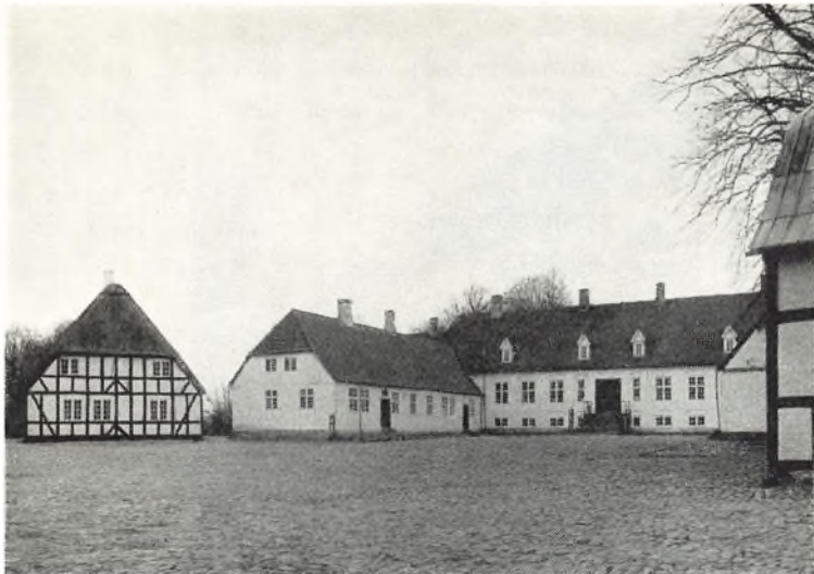
Hovedbygningen og gavlen af en af de gamle ladegårdsbygninger set fra indkørselen (fot. Niels Elswing).
