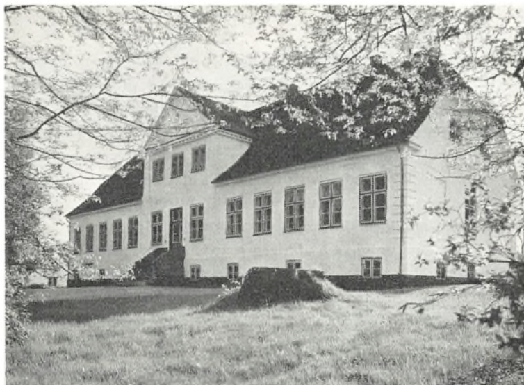
Hovedbygningen set fra haven (fot. Niels Elswing).
