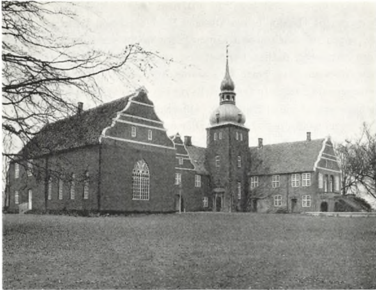
Hovedbygningen med kirkefløjen set fra parken (fot. Niels Elswing).
