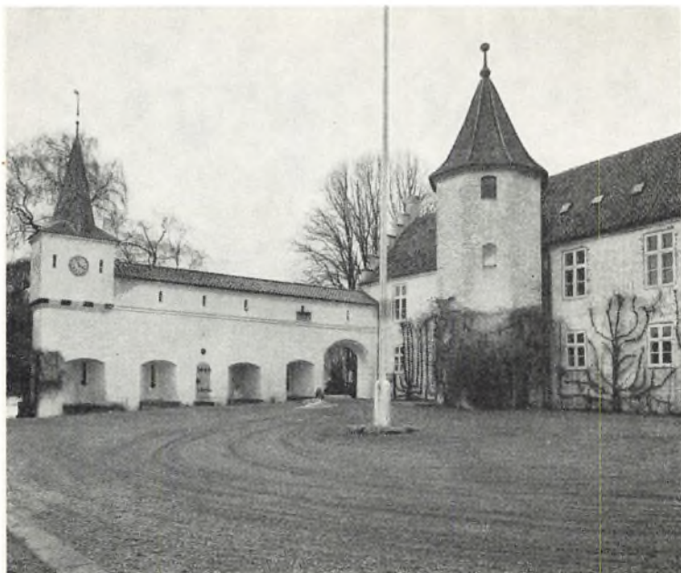
Hovedfløjen med spærremur set fra sydøst (fot. Niels Elswing).
