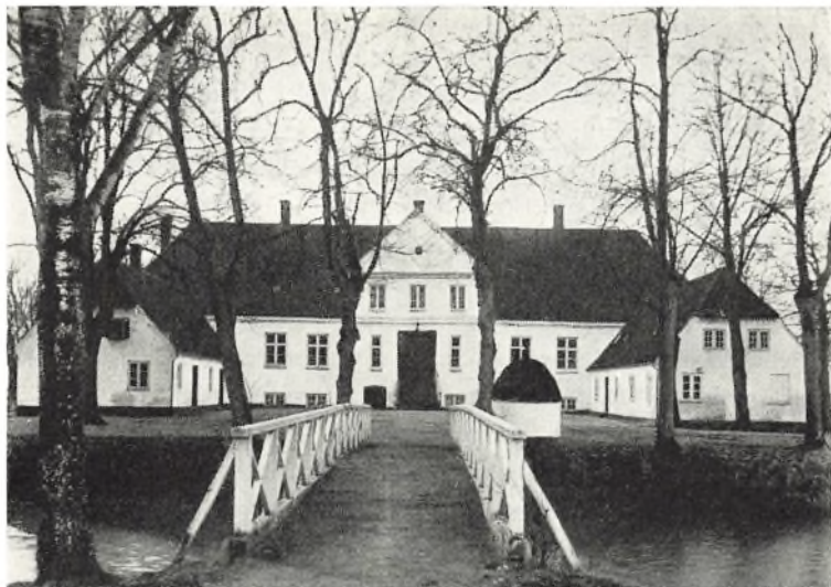
Hovedbygningen set fra indkørselen (fot. Holt & Madsen).
