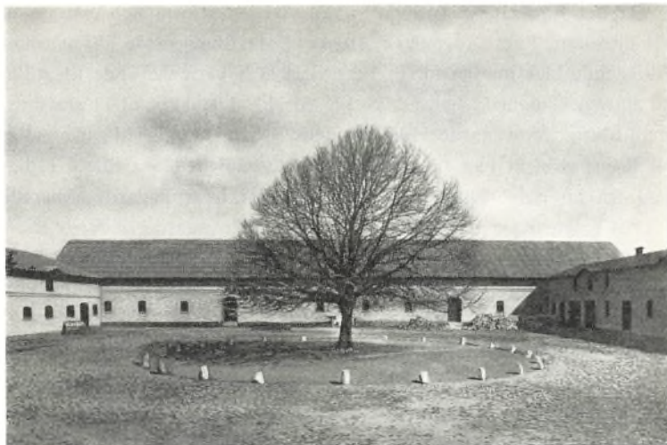
Avlsgården set fra hovedbygningen (fot. Holt & Madsen).
