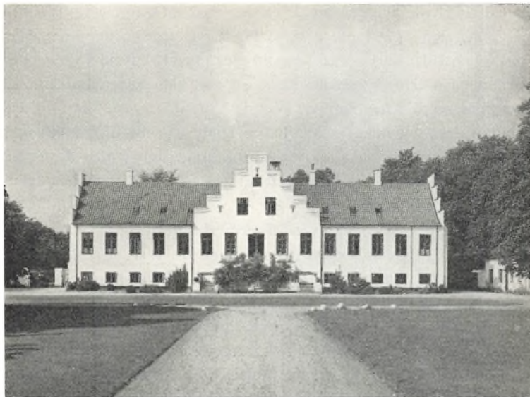
Hovedbygningen set fra indkørselen (fot. Niels Elswing).
