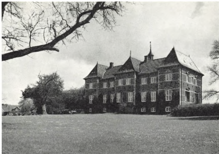
Hovedbygningen set fra nordvest (fot. Niels Elswing).
