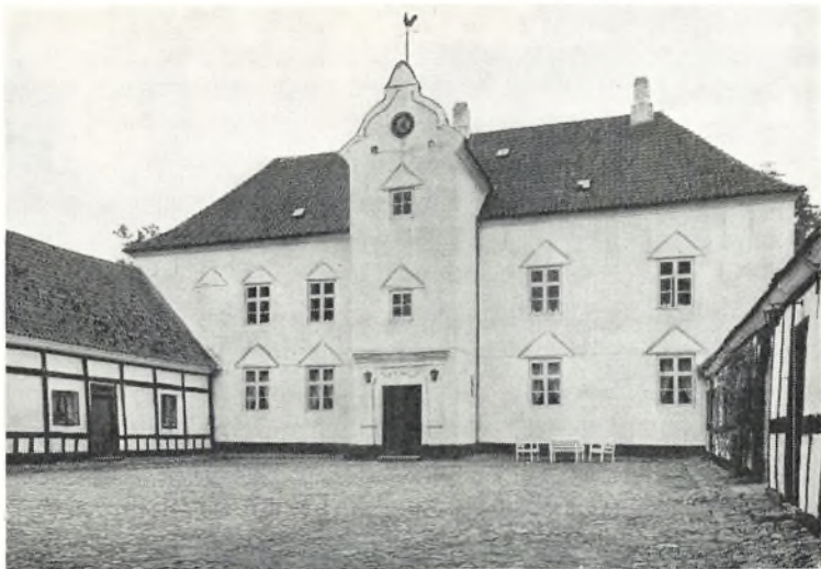
Hovedbygningen set fra øst (fot. Niels Elswing).
