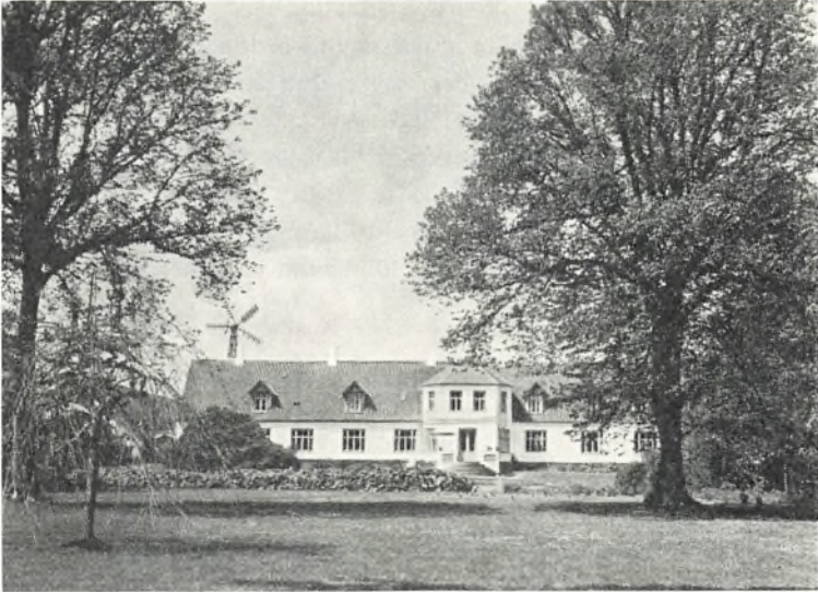
Den nu nedrevne hovedbygning set fra haven (fot. Holt & Madsen).
