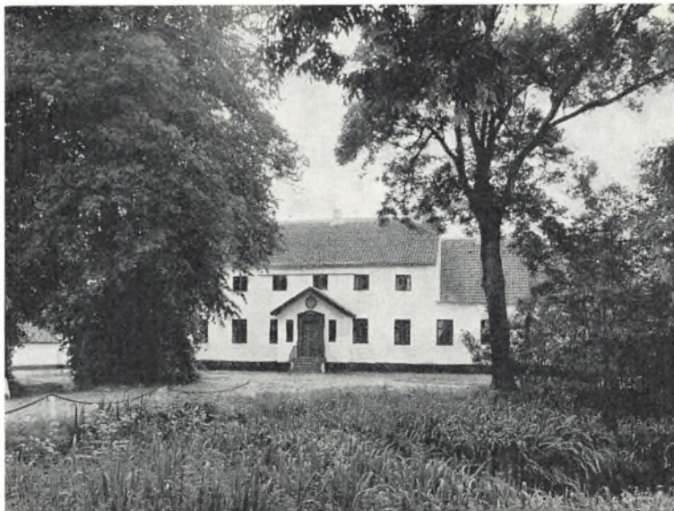
Hovedbygningen set fra øst (fot. Niels Elswing).
