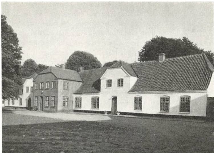
Hovedbygningen set fra gården (fot. Niels Elswing).
