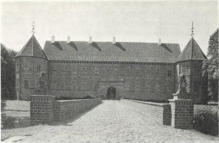
Hovedbygningen set fra øst (fot. Niels Elswing).
