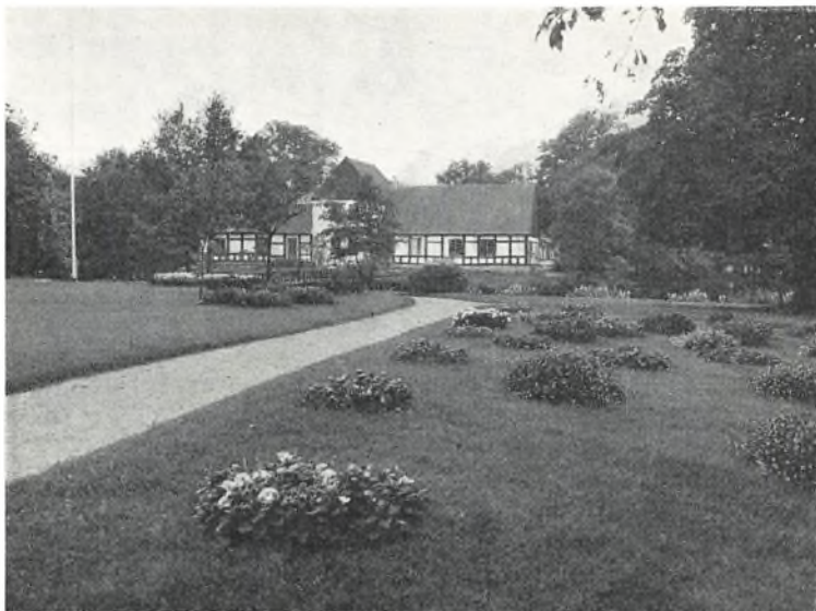
Hovedbygningen set fra øst (fot. Niels Elswing).
