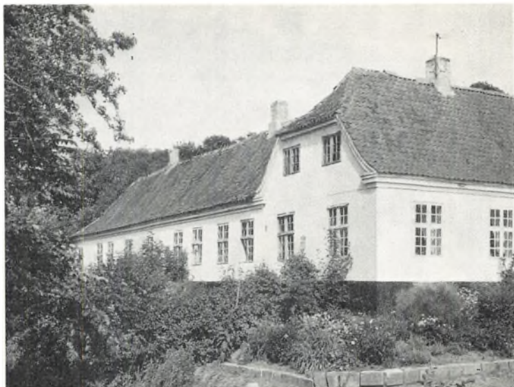
Hovedbygningens sydvestre hjørne (fot. H. H. Engqvist).
