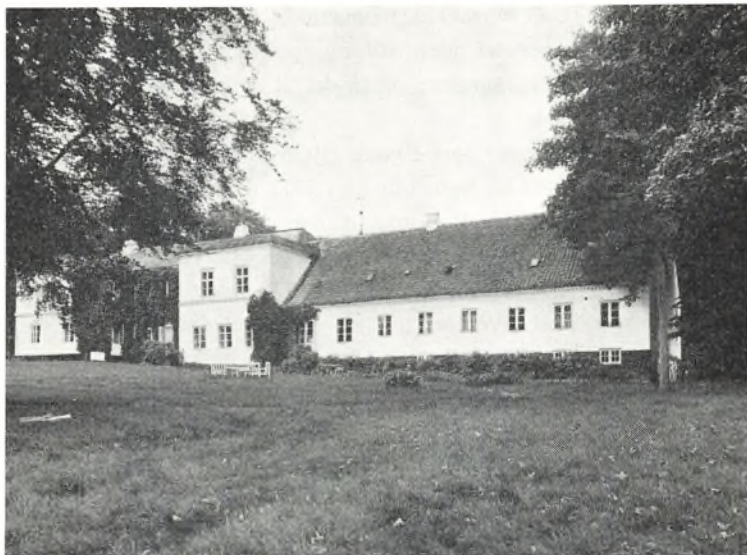
Hovedbygningen med »den italienske fløj« set fra syd (fot. Niels Elswing).
