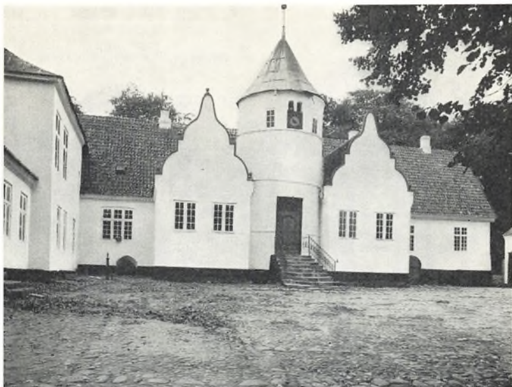
Hovedbygningen set fra øst (fot. Niels Elswing).
