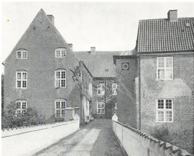
Indkørselen til hovedbygningen (fot. Niels Elswing).
