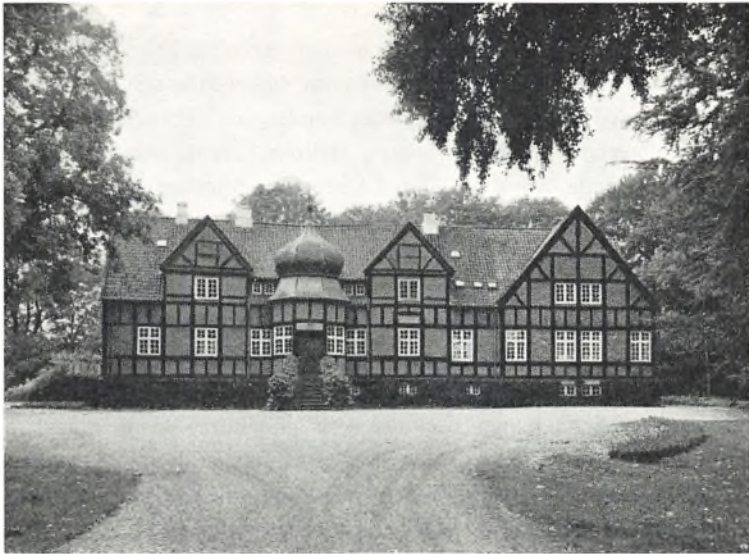
Hovedbygningen set fra øst (fot. Niels Elswing).
