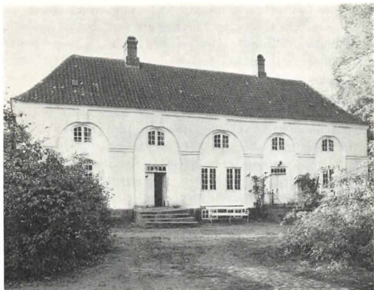
Hovedbygningen set fra øst (fot. Niels Elswing).
