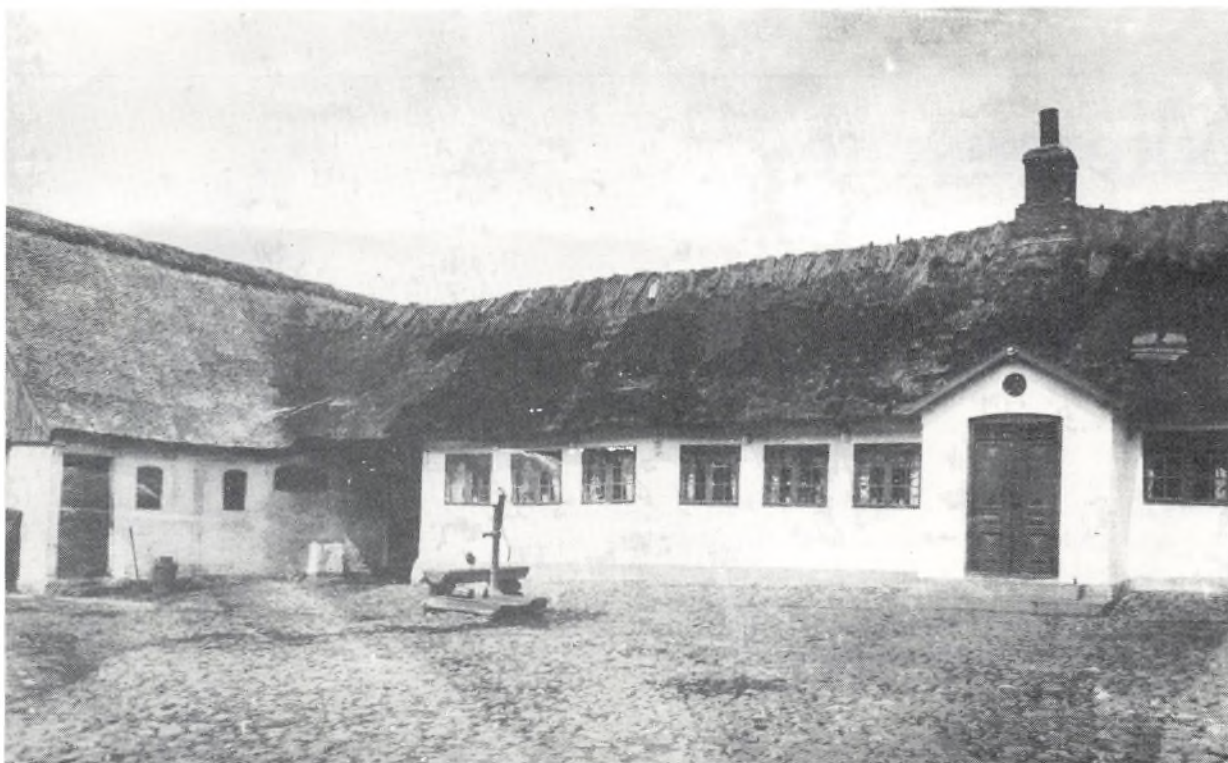
Korsbjerggård, Vridsløse Stuehuset, der fra Landboreformernes tid, brændte i 1928, sammen med hele gården. Korsbjerggård er en slægtsgård, nuværende ejer - Knud Larsen er 7. generation.
