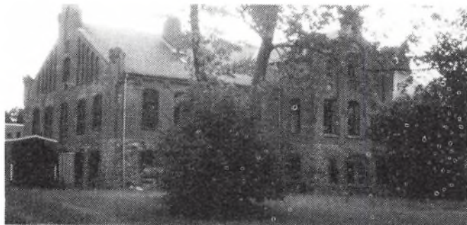
Forpagterboligen til Vilhelmsborg opført i midten af 1850'erne. Den høje kælder rummede godsets mejeri. Idag er der indrettet et prima spisested i kælderen og fra de gamle stuer og godskontor administreres Danmarks Nationale Hestecenter.
