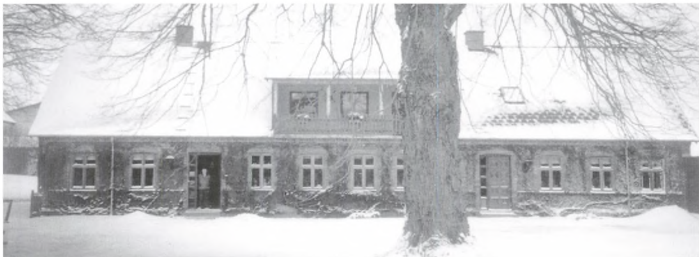
Hovedbygningen set fra gårdspladsen - marts 2005.
