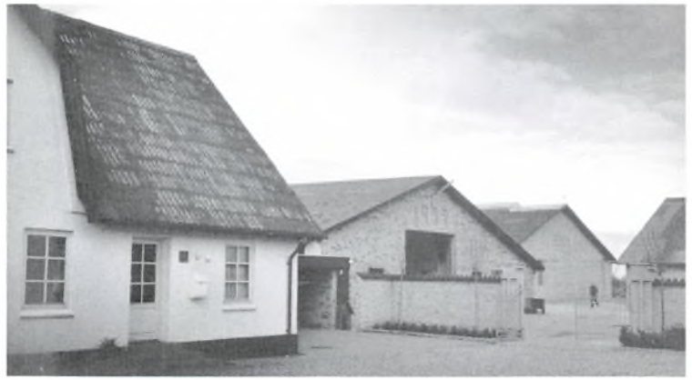
Højagergård fra gårdspladsen. De nye bygninger er opført over 30 år, men de danner en helhed, så selvom der er flere byggeperioder, så er her et eksempel på, at der kan skabes harmoni.
