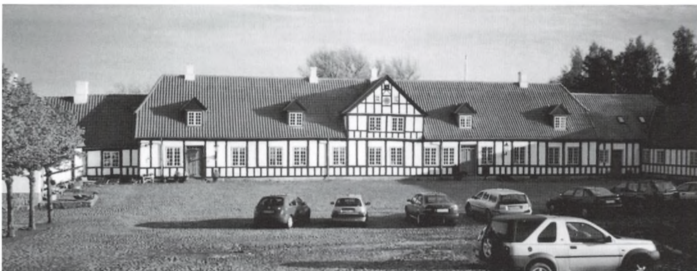
Tamdrup Bisgård, som fabrikant Alan Nissen købte i 1999, Hovedbygningen fra 1784 er siden blevet gennemgribende istandsat, men på en forbillig måde, så den har bevaret sin patina.
