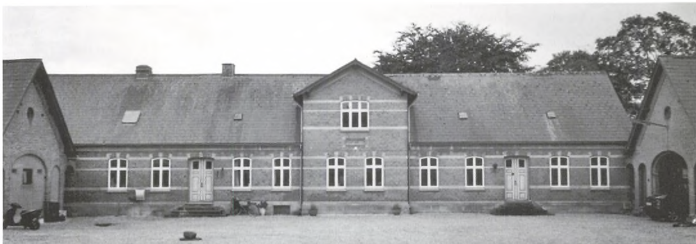
Kirkegårds bygninger blev opført efter brand i 1886. Det er et enestående byggeri, som tilmed er bevaret. Stuehuset er under istandsættelse, bemærk de nye vinduer.
