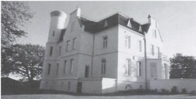
Buskmoses særegne hovedbygning fra 1887.
