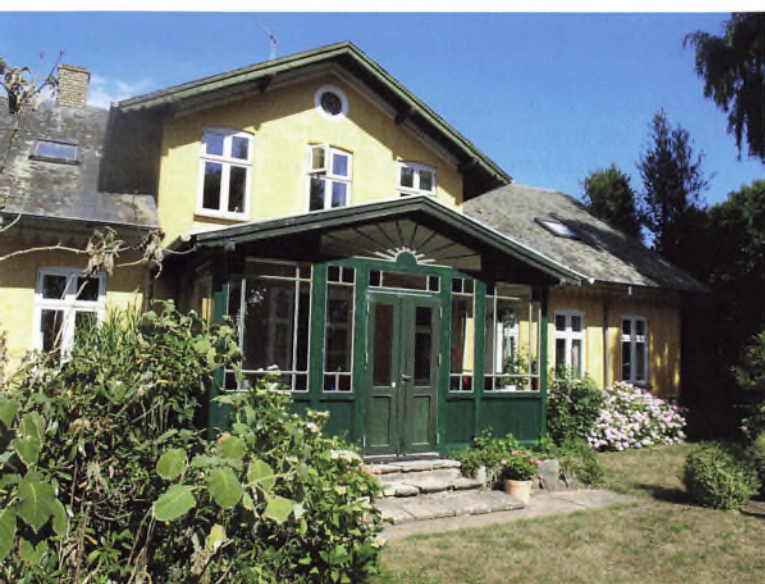
Stuehuset med den imponerende veranda, som nu er sat i stand.
