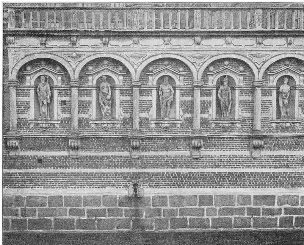
Fig. 20. Terrassen, østlige Del.
