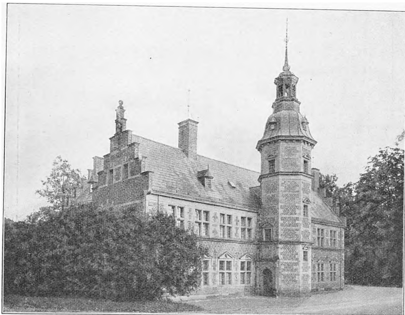
Fig. 5. Badstuehuset set fra Nordvest.
