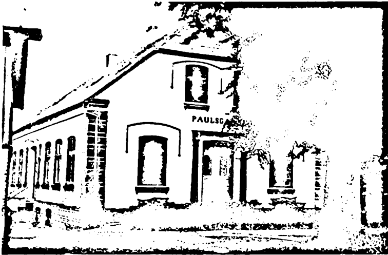
Vestre Paulsgård (Bmk 22). Gården skal være brændt 1631, og de derefter opførte bygninger bar årstallet 1632 (iflg. J. H. Riis). 1865 faldt ladebygningen sammen, og nye lader opførtes samme år. 1878 blev det nye stuehus opført. Fot. Bram van Leewen 1963.
