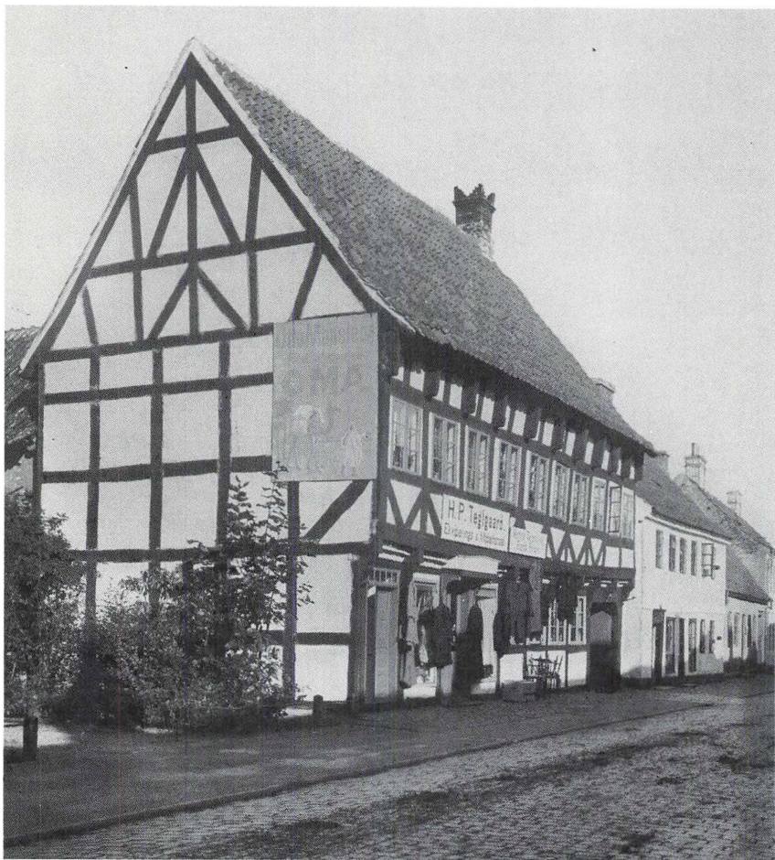
Nørregade 31, kaldet Braadts Gård, er et velbevaret og interessant bindingsværkshus med sine smukt udskårne lange tagremsknægte under taget. Ejendommen er opført mellem 1612 og 1615; men desværre har en nylig istandsættelse været noget hård ved huset. Det samme var Otto Mønstedts gavlreklame for Oma-margarine — et typisk eksempel på, hvad man i Køge-Fonden bekrigede under navn af skiltepesten. Fotografiet er optaget i 1914 af Hugo Matthiesen.
