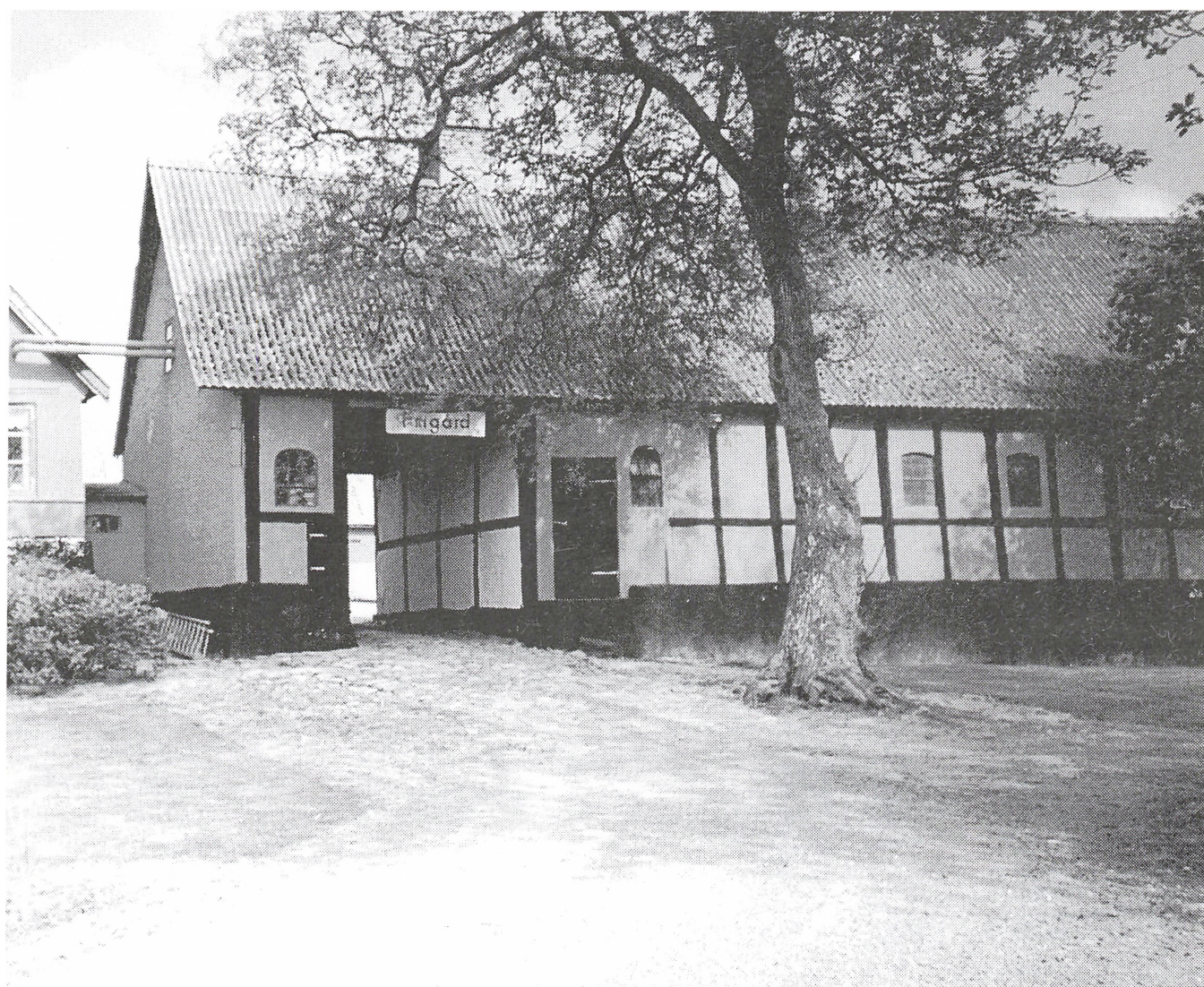
Frigård på Bornholm. Gården har været i slægten siden 1774 og ejes nu i 6. generation. Læs om Frigård på side 8 - 9.
