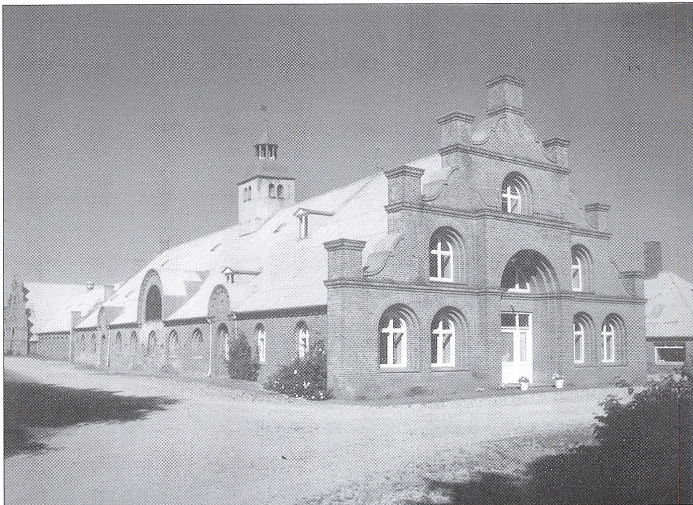
Egebaksande har ingen egentlig hovedbygning, men i forlængelse af staldbygningen indrettedes bolig til kajtajn Jagd, og indgangspartiets herskabelighed mangler ikke noget.
