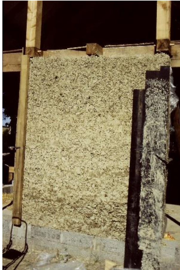
De ca. 30 cm tykke lervægge består af en blanding af ler (vand), høvlspåner og snittet halm. Leret er almindeligt blåler fra Nivå.
