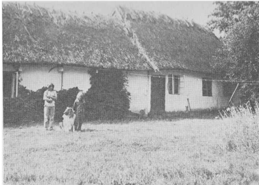
Del af stuelængen til Vesterager, set fra nord fra haven, tilhøjre tilbygget øverstestue med udgang til haven. Foto H. C. R. 72.
