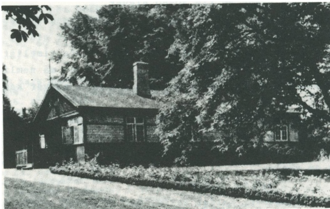
Nyrops Hus før restaureringen i 1974.
