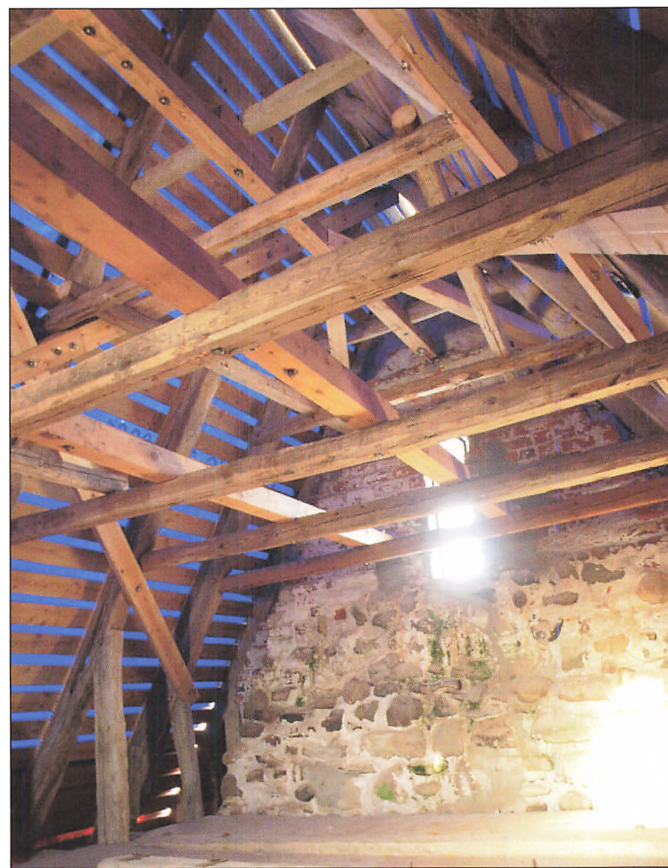
Tagværkets loftsrum set mod nordvest.
