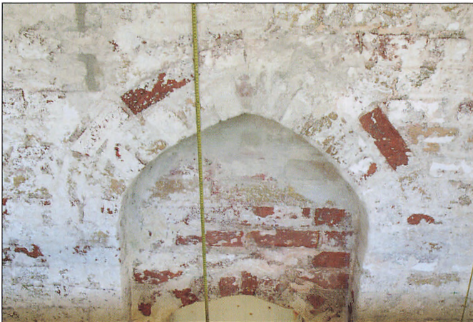
De gule munkesten anvendt dekorativt ved indgangspartiet.
