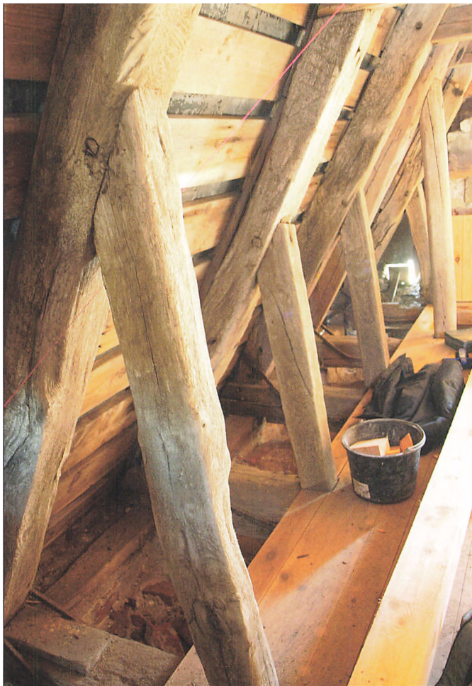
Østsidens spær med spærstiver i forskellig længde, set mod syd. Spærstiveren forrest i billedet tilhører spær nr. 3. Sammen med spærstiveren til spær nr. 6 er den væsentlig længere end flere af de øvrige.
