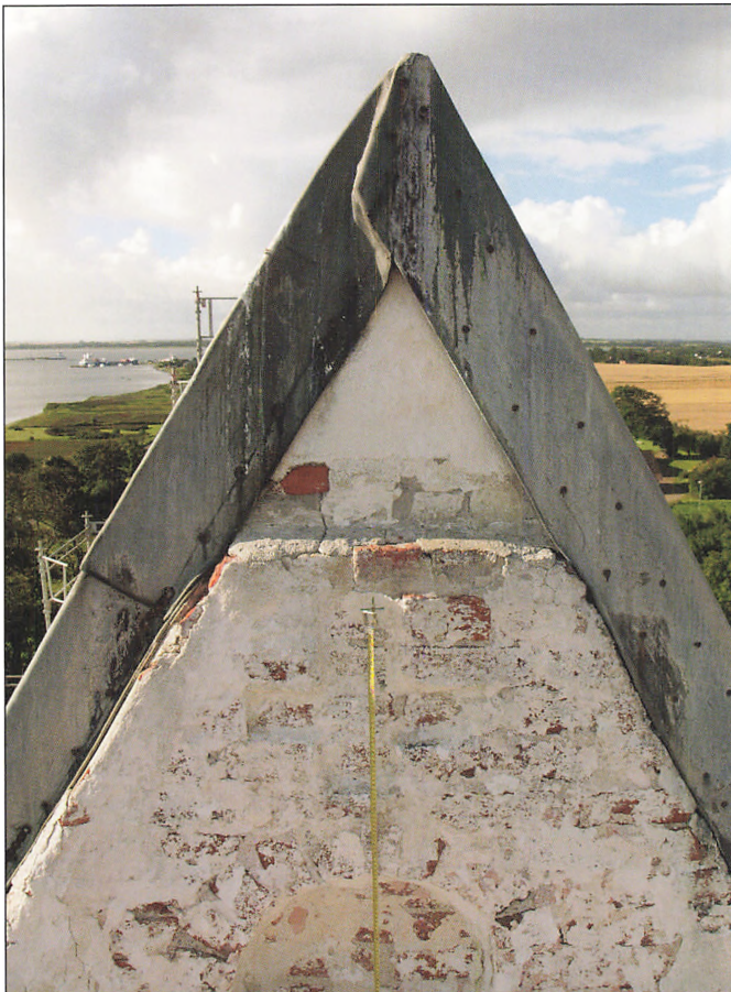
Tårnets øverste gavltrekant med den senere tilmurede del trukket lidt ind. Bag det ophængte målebånd anes det tilbagetrukne kors i murværket.
