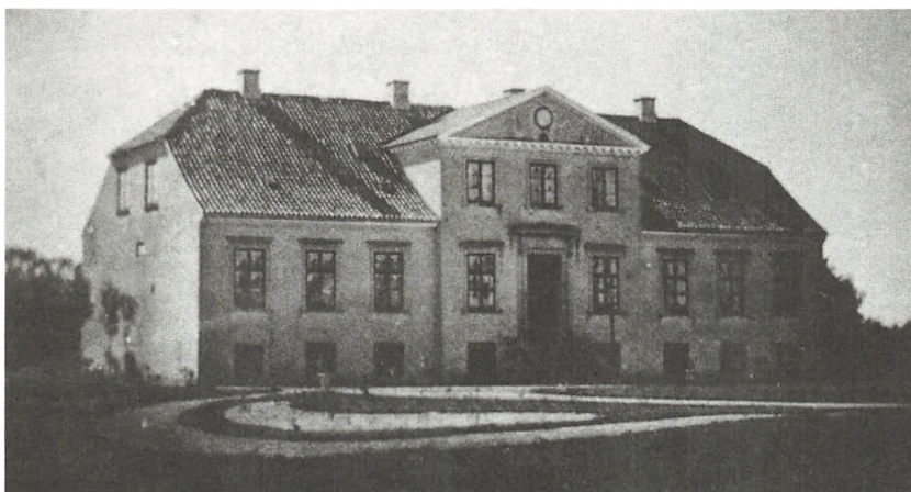
Fuglsang 1866 – set fra nord – umiddelbart inden nedrivningen.
