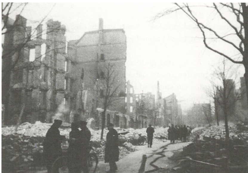
Maglekildevej set fra Amicisvej. Seks døde men ti overlevede i bunkers. Foto: R.N., 27. marts 1945. Bemærk de sorte nedhængende centralvarme- apparater!
