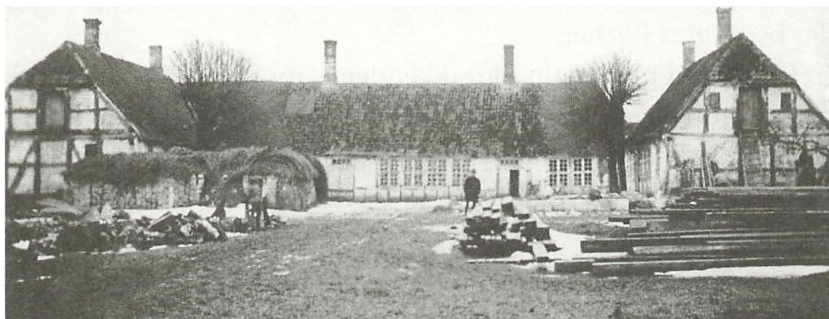
Gjerdrups gamle hovedbygning, umiddelbart før nedrivning. Foto fra 1863.
