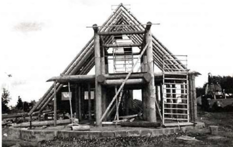
Rundtømmer huskonstruktion i den økologiske landsby Torup
