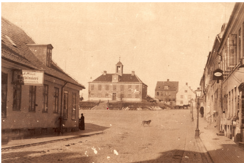
Hillerød Torv med det gamle rådhus og med løsgående hund, før 1887. Foto: Carl Rathsach.
