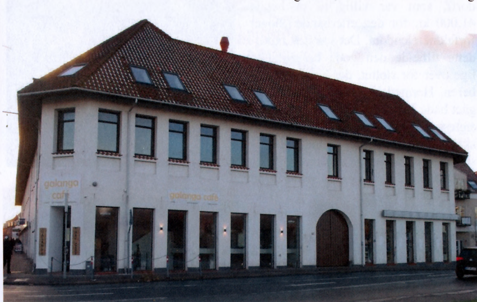
Slotsgade 2. Foto 2017 ved Jeppe Tønsberg.
