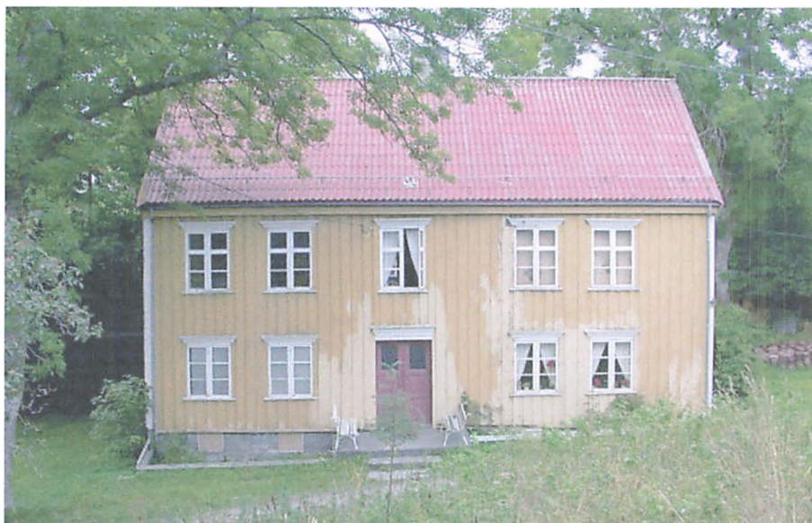
Fig. 84. KNUDTZONDALEN's hovedbygning; sydfacaden 1995. Foto: Christ Allan Sylthe, Fylkeskonservatoren. Nordmøre Museum 1995.
