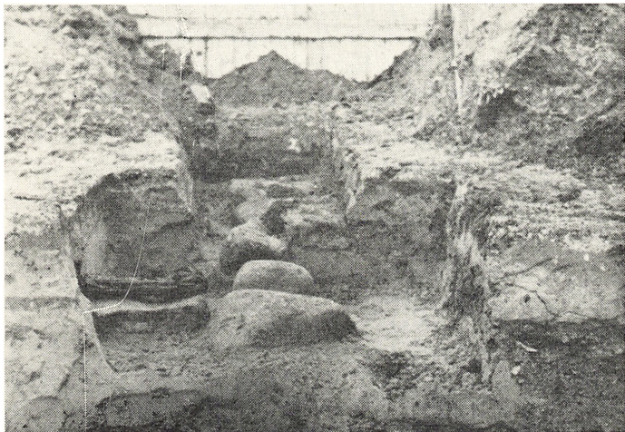
Blot et Kvarter under den nedrevne Præstegaards Grundvold ses en halvforkullet Fodbjælke liggende urørt paa en Række Syldsten fra Branden 1749, da „den røde Hane“ galede over Dorschæus' Borgmestergaard. I Baggrunden Plankeværket mod Adelgade. (Viborg Stiftsmuseum fot.).
