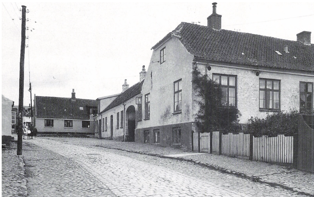
Det gamle Sygehus i Sønderbyen i trediverne. Bemærk de ujævne fortove af vidt forskellig bredde.
