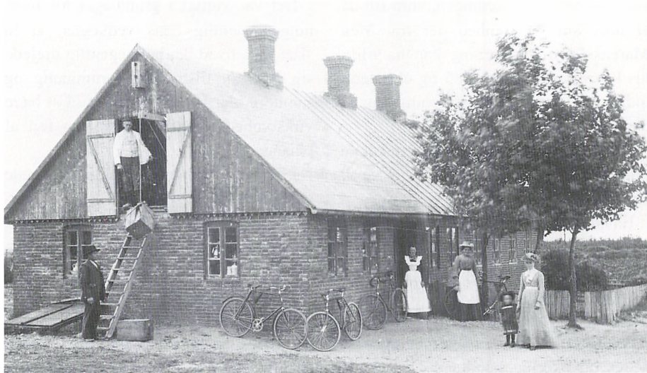
Den første bestyrelse for Fly brugsforening lejede Laust Olesens hus for 50 kr. årlig. Efter et års forløb købte man huset for 1000 kr. Laust og konen fik lov at bebo lejligheden på livstid, mod selv at sørge for vedligeholdelse af den. Først i 1913 opførtes en ny brugsforeningsbygning lige overfor på den anden side af vejen (Dåsbjergvej). Billedet her er sandsynligvis fra omkring 1900 (Foto: Lokalhistorisk Arkiv for Viborg Kommune).
