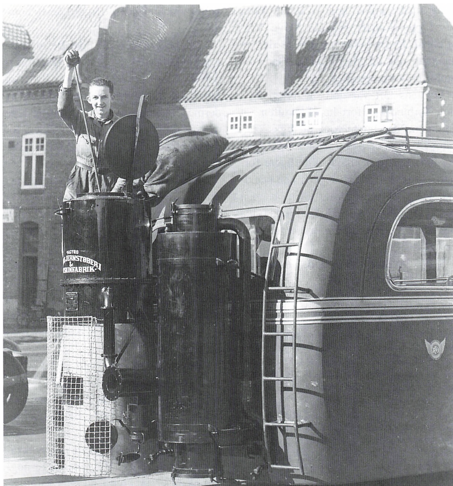
WODSKOU gasgenerator med påmonteret ekstra gasbeholder. Foto ca. 1941.
