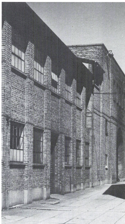
Den smalle passage langs støberiet. Foto 1965.
