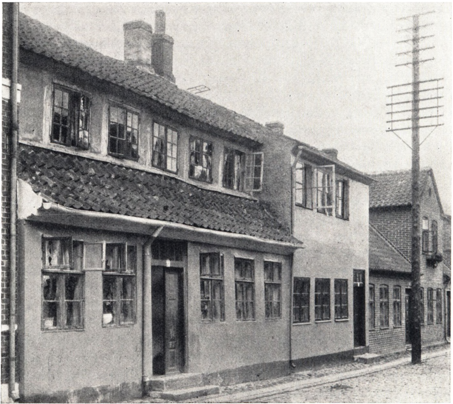
Hus i Søndergade.
