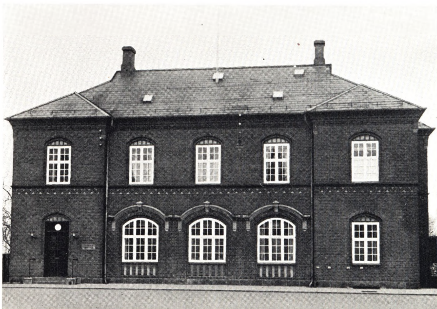
Administrationsbygningen (tidl. Sorø Bystation).
