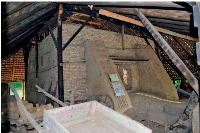
Teglloven har været af samme type som denne fra Bladstrup Teglværk. Ovnkammeret er åbent opadtil, men hen over ovnen og arbejdsområdet uden om ovnen er der en teglhængt tagkonstruktion. Bladstrup Tegllovn er flyttet til Den Fynske Landsby i Odense.
