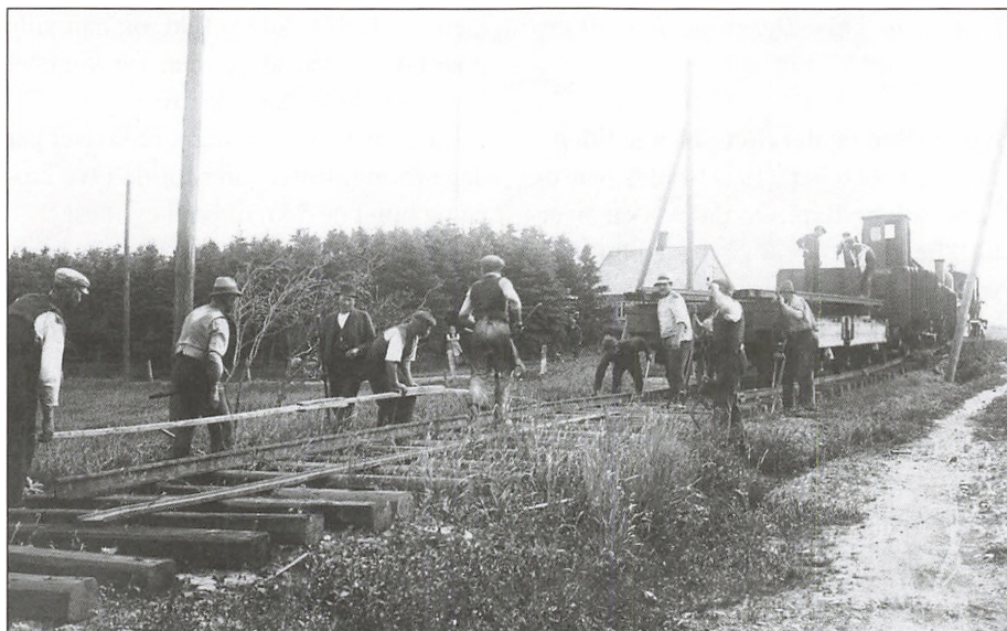
Sporarbejde på Vestsallingbanen. Ca. 1923.
