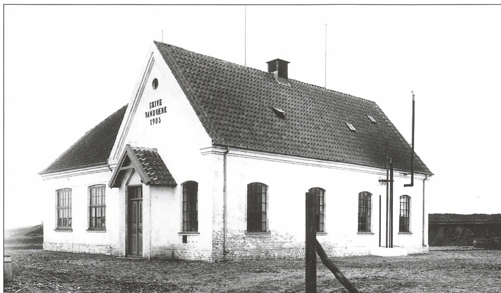
Vandværket ved Lundhede. Hovedfløjen rummede maskinanlægget, og i fløjen til venstre boede den medarbejder, der passede værket. Bygningen eksisterer i øvrigt fortsat. Skive byhistoriske Arkiv.
