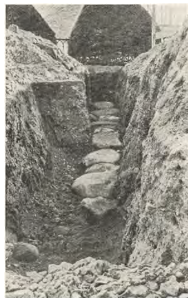
Fundament af Bryggerhusets Sydmur, set fra Vest
