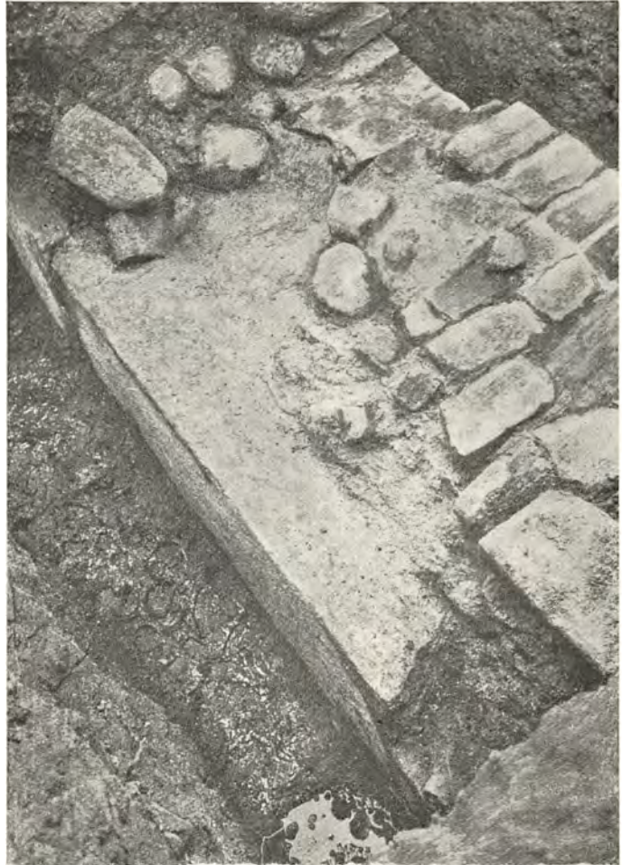
Samme Brudstykke af Borghusets Nordmur. — Den lange Granit-Kvader paa Murens Nordside er den længste af alle de fundne Kvadere. Den er nu taget op og er opstillet ved den nuværende Hovedbygning's Sydgavl, udfør Brysketavlen
