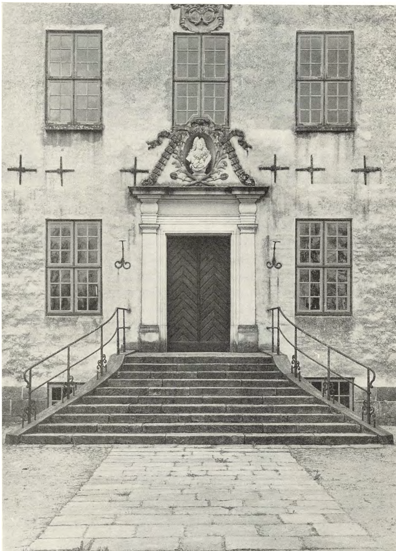
123. Den i 1918–19 temmelig frit rekonstruerede portal, der er bredere end den oprindelige (sml. den originale indskriftssten på fig. 122 og guirlandernes forhold til overliggeren på fig. 33). Trappen har fået en form nogenlunde svarende til den, der var i brug på en tidligere tid (sml. fig. 112 og 117) helt forskellig fra den oprindelige (sml. fig. 107).
