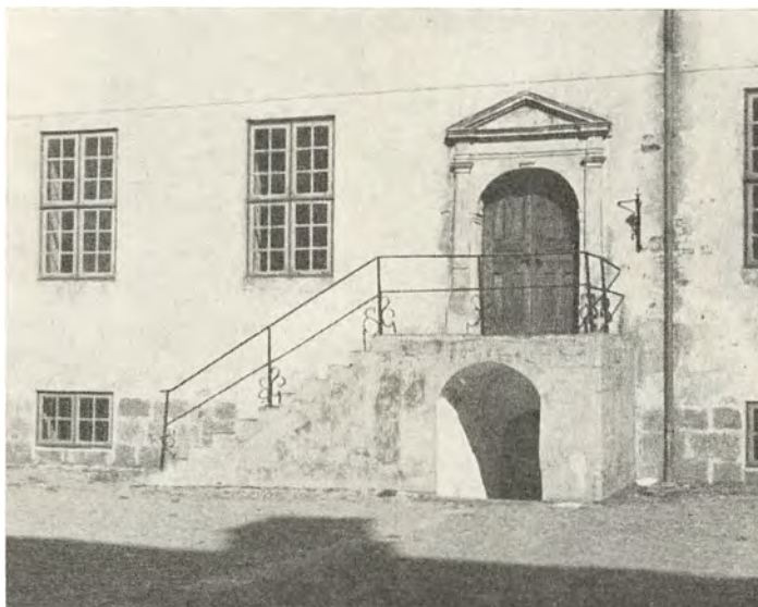
34. Østre sidefløjs portal.
