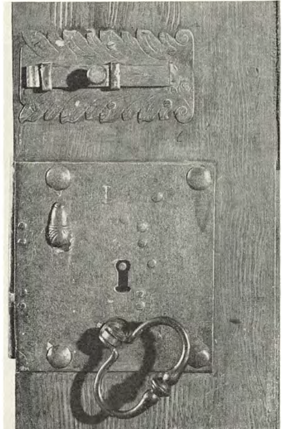
170—71. Laasetøj (hollandsk laase og skufriqler) på døren, der er vist som fig. 174.
