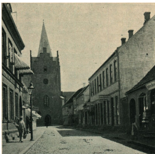
Storegade. Længst tilhøjre ses Holstvigs Hus, derpaa Dyrlæge Dyekjærs.
