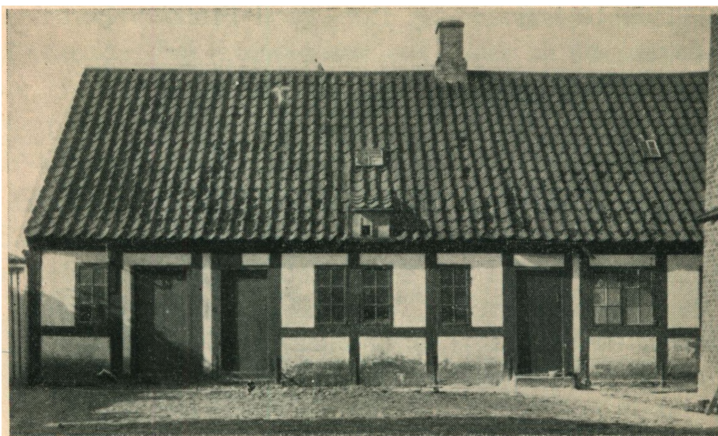
Det af Kobbersmed Perch ca. 1754 opbyggede Bindingsværkshus, som senere af P. Jensen fyttedes over som Baghus og endnu findes i „Messen“s Gaard.
