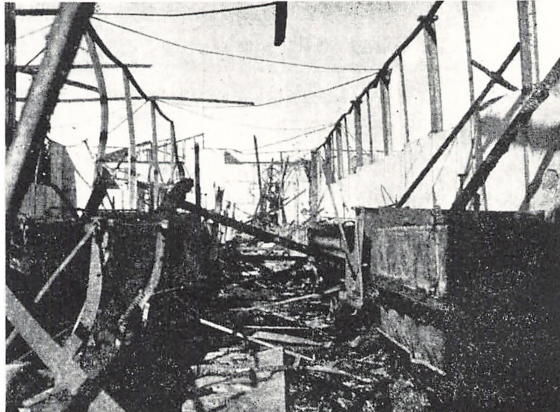
Jærredet Jern, brændt sammen, smuldes, at man ikke kan se, hvor den ene Iagn begynder, og hvor den anden ender. Skinnerne, Vognene stod paa i Remisen, har krænket sig i Varmen, og Vognene sunket ned i Gravene, som man henstøvede ved Reparation. Olie, Træværk og Lak og de oliemøttede Gulve har givet Ilden rigelig Næring.
