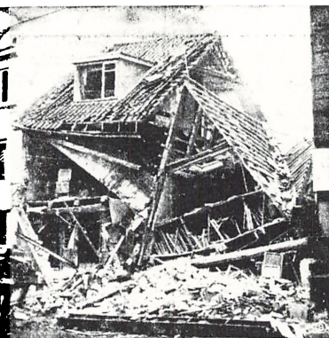
De sammenfaldne Ruiner af Chokoladeforretning »Wilson« og Kunsthändler Hassings Hus.
