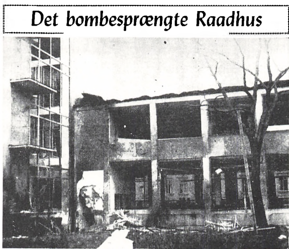
Bliver Bomben, der i Nat laavede store Ødelæggelser i Aarhus Raadhus, laa, ses paa dette Billede. Den var anbragt i Kragten, hvor der er skaaet et stort Hul i Muren. Man laar ogsaa et Indtryk af de store Skader paa Bygningen, der rummede Livvognskassen.
