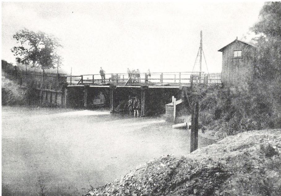
Slusebroen, hvor nu Vester Allé føres over åen.
