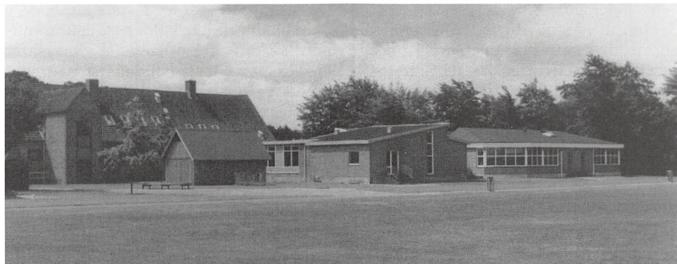
Kværs skole med de seneste tilbygninger set fra nord i 1997. Foto: G. Conradsen.
