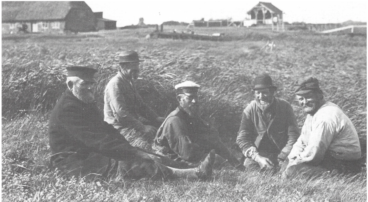
»Vadehavs bønder«, som har lejret sig i græsset ud for hotellet og anløbsbroen i Kongsmark, fotograferet omkr. 1910. Østenden af huset til venstre var pakhús for gods fra overfarten. Yderst mod vandet (til højre) ses rampen til den hvidmalede anløbsro. Fot. T. Voswinkel i Historiske Samlinger, Aabenraa.
