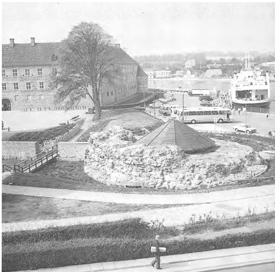
Fig. 4. Sønderborg slots nordøstre rondel og porthuset efter frilægning og restaurering, 1984.
