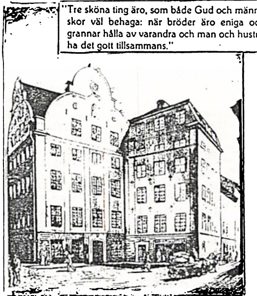
Hans Bremers hus (Grillska) vid Stortorget's östra sida i Gamla stan.
