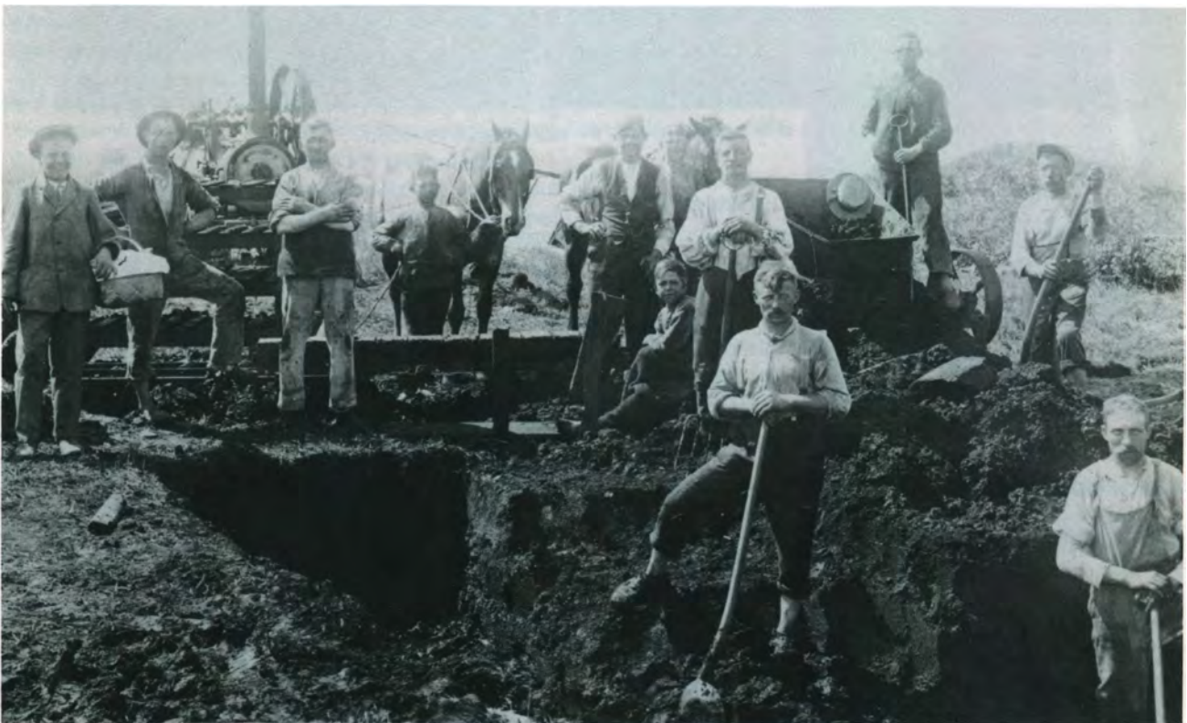
Fra opførelsen af Svinningeværket maj - november 1913. Bemærk det hestetrukne damplokomobil.
