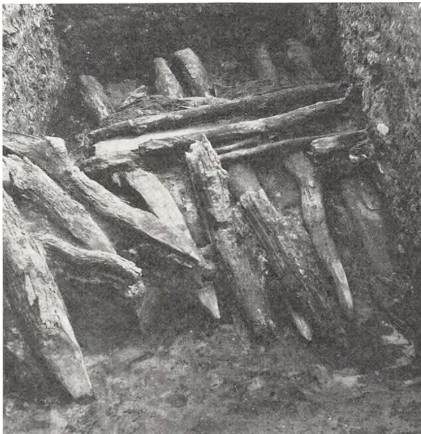
Figur 4. Palisader, væltet ud i voldgraven, set inde fra borgbanken mod voldgraven. Tværtømmeret har skullet fordele jordtrykket og tætn mellemrummet mellem palisaderne.
