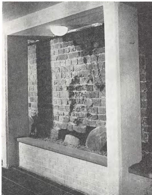
Fig. 19. 1971 frilagt bæremur til porthvælvets nordvest-væg.
