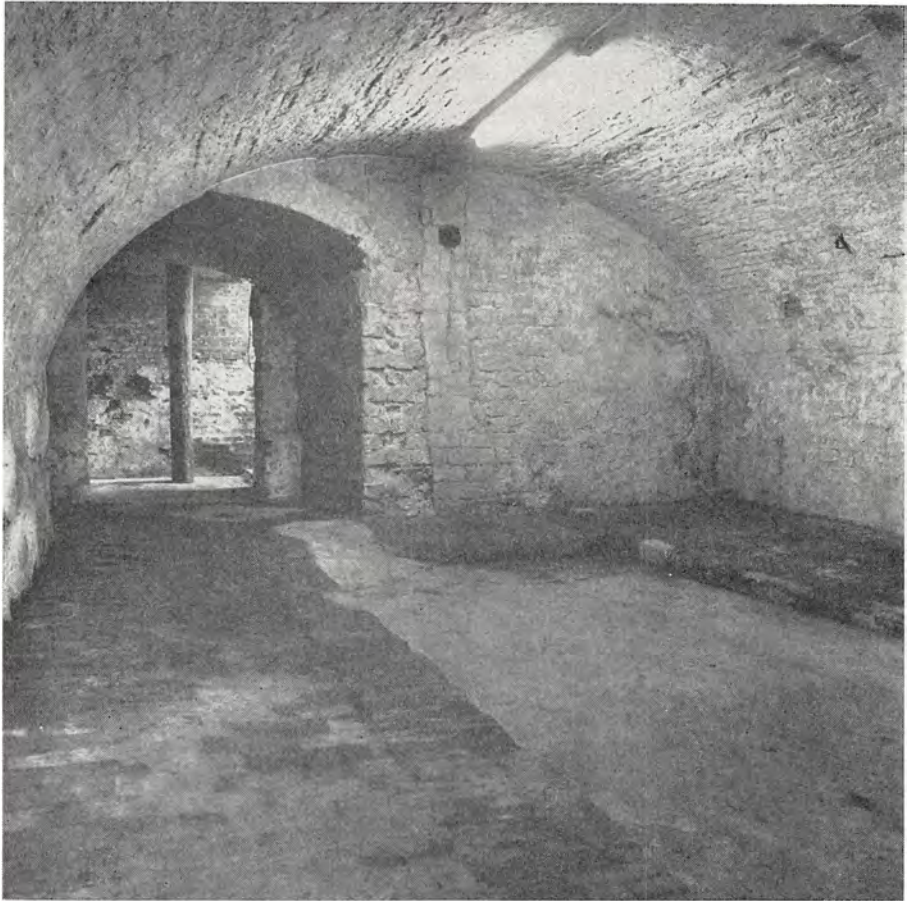
Fig. 25. Den eneste bevarede bygningsdel af slottet, kælderen under modtagelsesrummet i nordfløjen (o. 1600?), set fra syd. Beskrevet i 1706-inventariet, s. 17/18.
