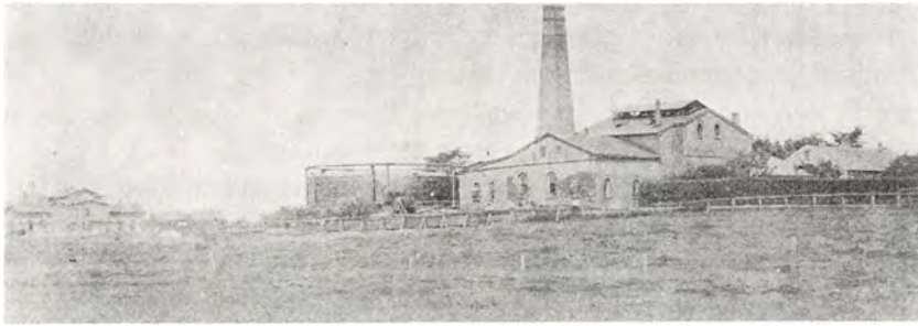
Fig. 27. Gasværket på slotsbanken (1865). To marskbanegården, th bestyrerboligen.
