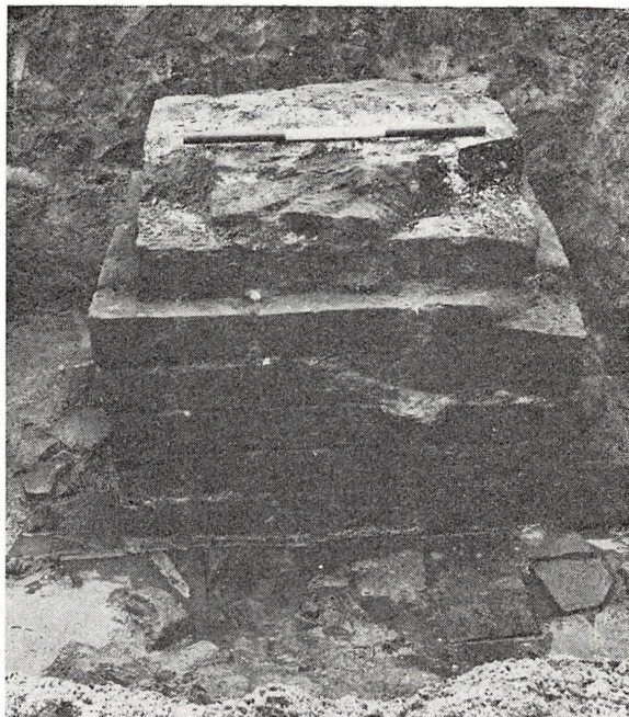
Fig. 4. Søjlefundament, jvf. fig. 3. Under munkestenene skimtes det rammeformede træfundament, hvis konstruktion er skitseret th. (1:50). Fot.: Fl. Rieck.
