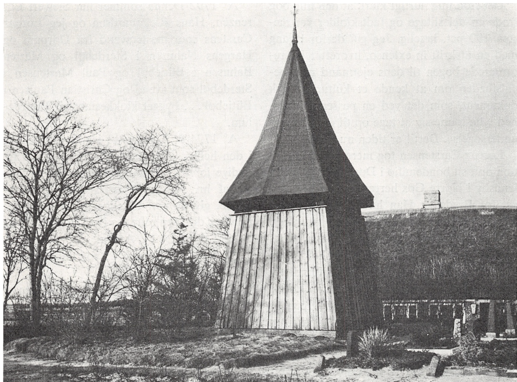
Klokkestabelen i Bordelum, som Lorenz Carstensen var med til at bygge. I en af bjælkerne ses endnu i dag navnene MARTEN BAHNSEN BUTTGEBUL og CHRISTIAN PAULSEN ANNO 1793. Foto i Landesamt für Denkmalpflege, Kiel.
