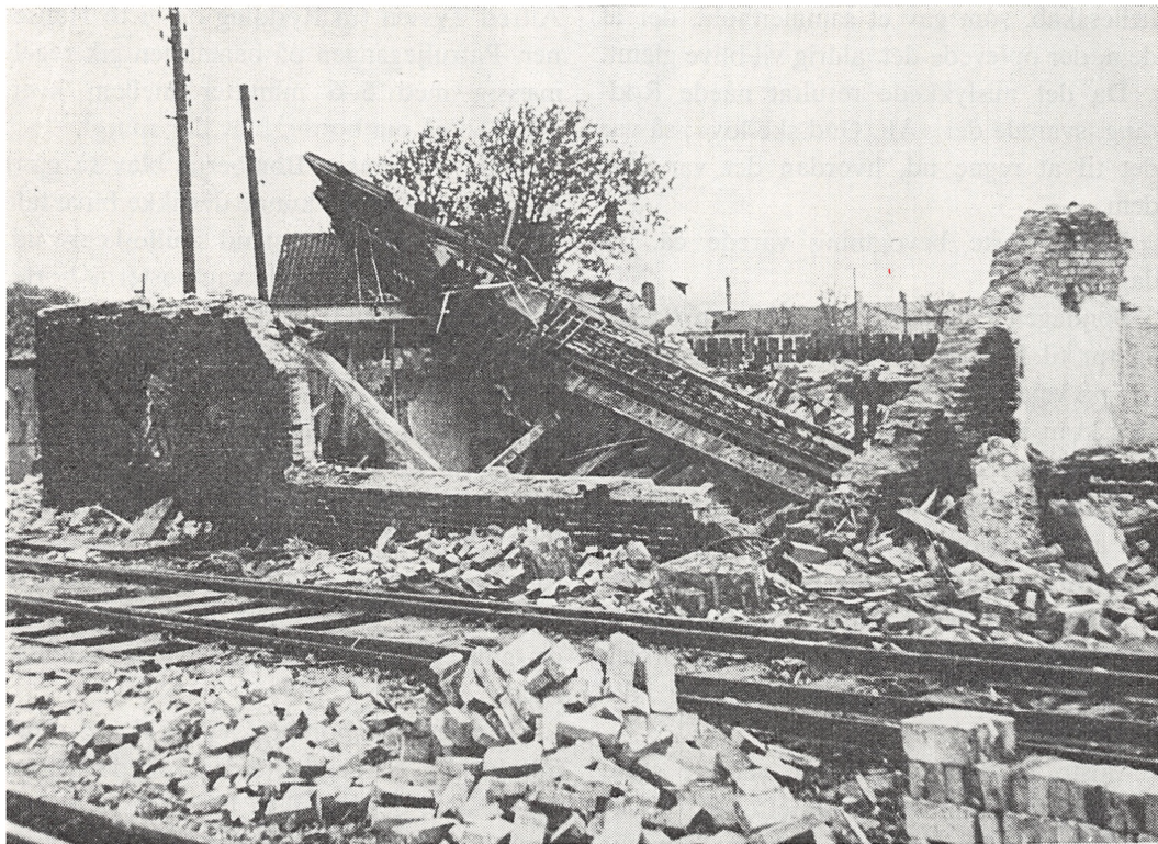
Saboteret blokpost ved Tinglev Station. Sprængningen fandt sted umiddelbart før kapitulationen. Foto: Th. Christensen, Åbenrå. Historiske Samlinger, Landsarkivet, Åbenrå.
