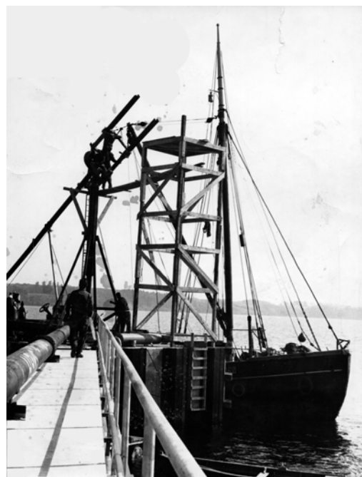
Slangetårnet ved pieren på Skærbækværket
