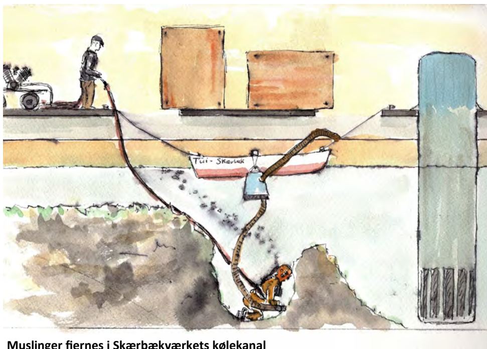
Muslinger fjernes i Skærbækværkets kølekanal
