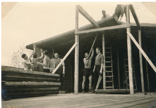
Svend er med til at bygge barakker i Padborg
