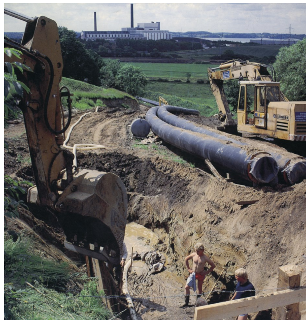
Der graves fjernvarmerør ned ved Kraftværksvej
