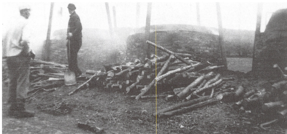
Kulsviere i gang ved milerne. De fire lodrette pæle ved hver mile er skorstene. Foto: Privat.
