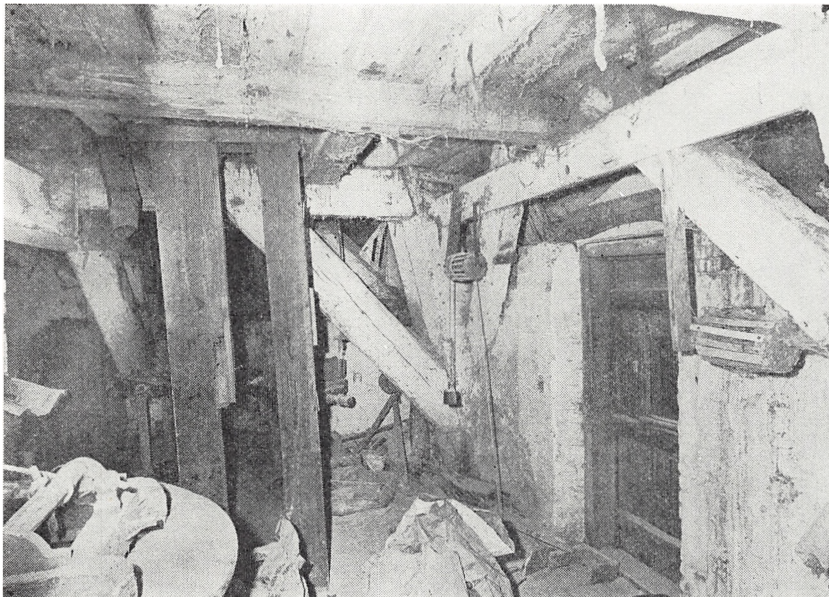
Fig. 2. Interiørbillede fra kværnloftet 1964 med møllens signalapparater. I signaltønderne er anbragt nogle bjælder, de såkaldte skvalderklokker. Ved et snoretræk fra stueetagen kunne man give signal til mølleren.
