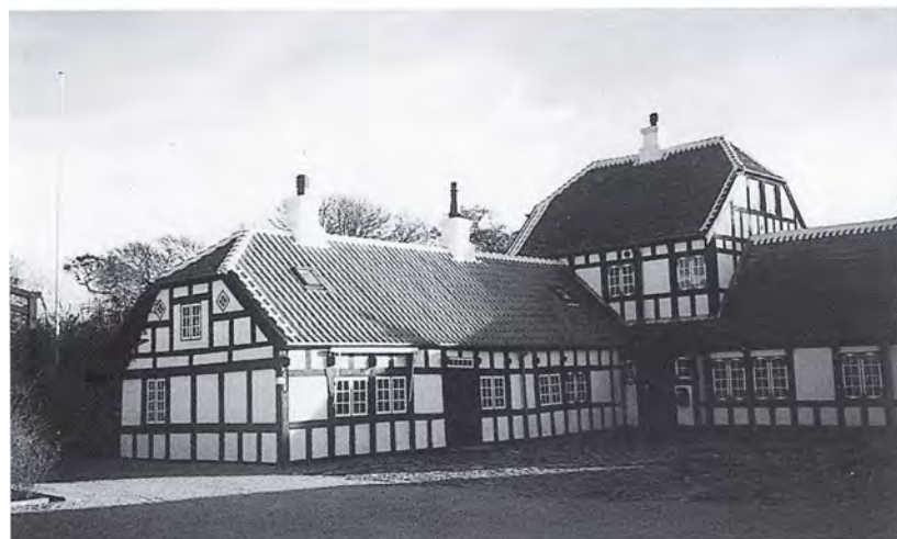
Sidehuset øst for gårdspladsen. Et særdeles smukt bindingsværkshus på 11 fag. Huset har altid været teglhængt og oprindelig kun med én skorsten. Der er anvendt såvel ege- som fyrretræ i bindingsværket. I bygningen var der bl.a. køkken, bryggers, pigekammer, vaskestue, bagerstue samt materialrum.
