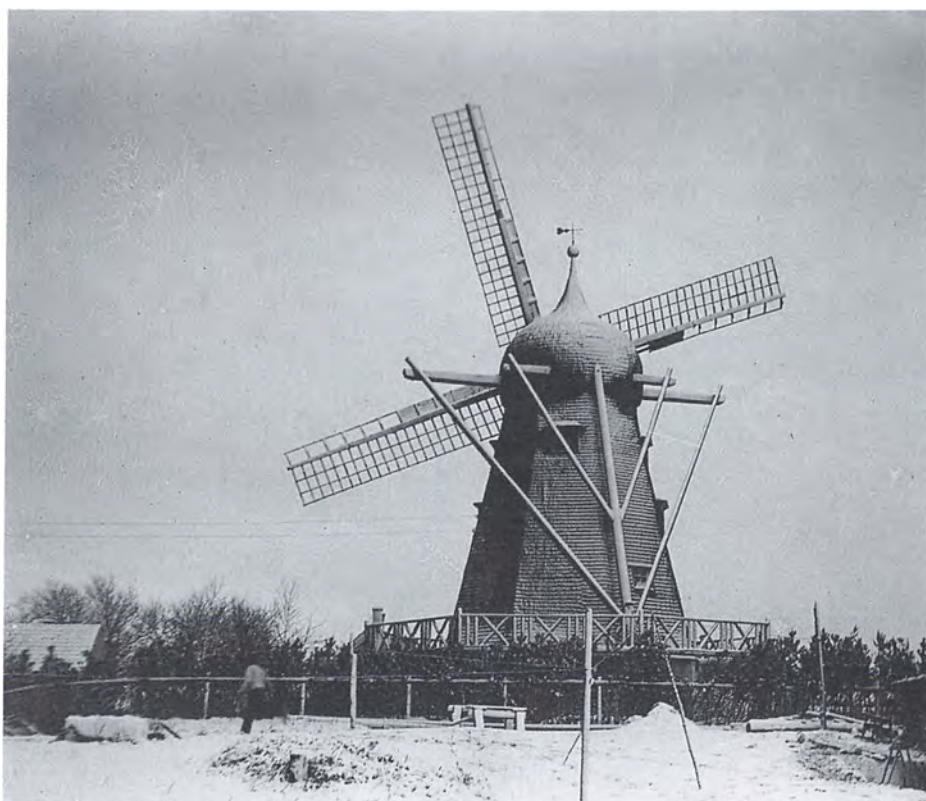
Møllen på Skovvej efter istandsættelsen i 1920, her set fra øst. Foto Christen Justesen. Tilhører Christen Justesen.
