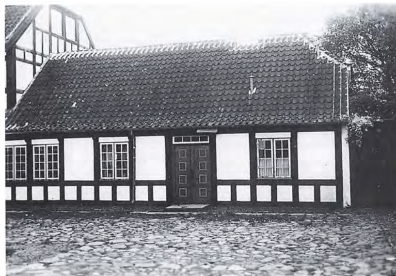
Den ældste del af Søren Møllers Gaard, bygget omkring 1830-33. Oprindeligt opført i 11 fag, men de to østligste fag indgår i Tuxens 2-etagers bygning mod øst fra 1902. Huset havde et udskud mod nord på 4 fag, hvilket er årsagen til den tilbagetrukne indgang i gårdens hjørne. Fotos af forfatteren.
