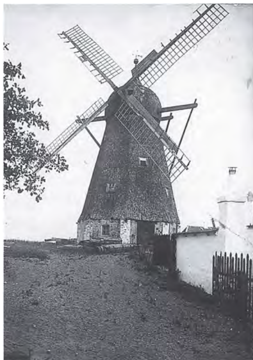
Søren Møllebyggers første Skagensmølle fra 1825. Møllen blev flyttet fra Toldergaarden til Boyesens Klit ved Skovvej i 1884, hvor den fungerede som mølle indtil 1918, hvor den blev købt af arkitekt Christen Justesen. Han satte den i stand og indrettede dens indre til beboelse. Her ses møllen i 1918 før istandsættelse. Foto Christen Justesen. Tilhører Christen Justesen.
