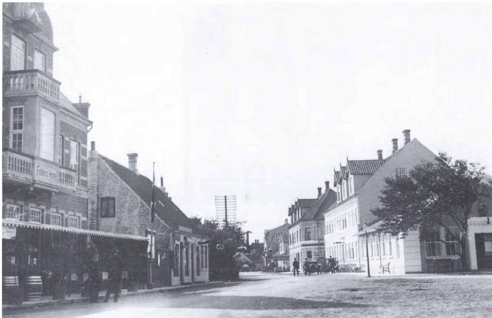
Sct. Laurentiivej ca. 1910. Til venstre Foldens Hotel, opført i 1908. Bagved bagermester Johan Gerhart Jensens forretning. Til højre Skagens Hotel hvis store bygning blev opført i 1884, mens den nærmere liggende galionssal blev opført i 1891. Over indgangen til galionssalen ses tvillingegalionsfiguren fra den franske skonnert Pauline et Marie, som strandede den 9. december 1866. På nordsiden af vejen ses et af de tidlige automobilkøretøjer i Skagen. Foto Kathinka Møller.
