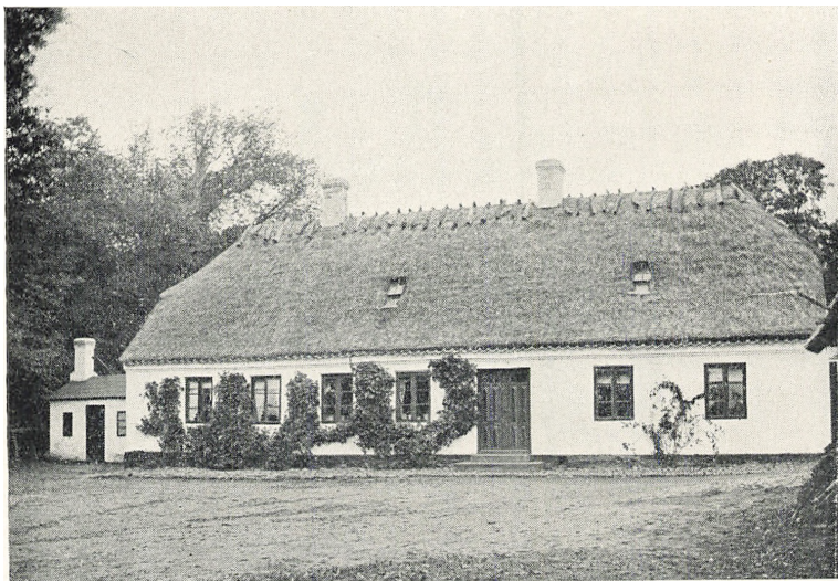
Hove gl. Skole, opført 1834.
